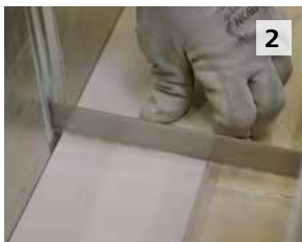
Je découpe la modénature DécoProfil à l'aide de la scie avec lame spéciale
