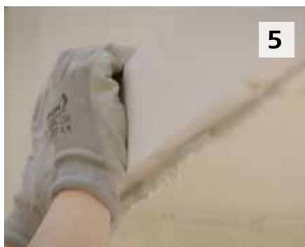
je pose l'encadrement avec un joint 6 mm
